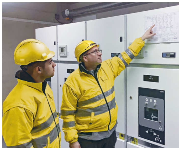
Les tournées d'inspection du méga-chantier font également partie du quotidien.
