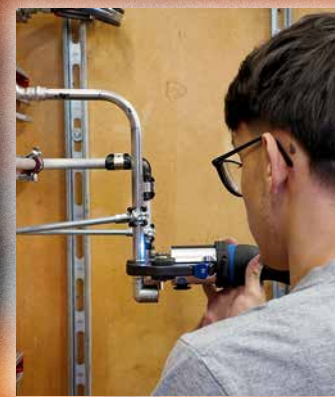
Les techniciens sanitaires réalisent eux aussi des assemblages durables, sans aucune soudure.
